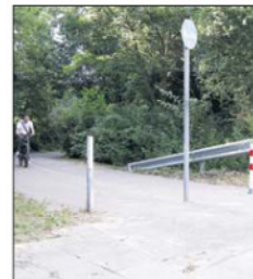
Gleich drei Pfähle stellen sich dem Radfahrer zwischen Planstraße D und Wiesenstraße in den Weg – einer hätte auch gereicht. Fotos: cb
